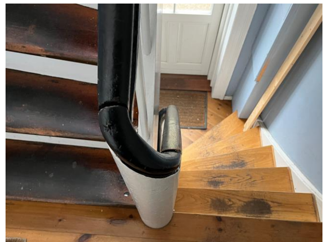
Foto 6: Indgangsrepos på bagtrappe
