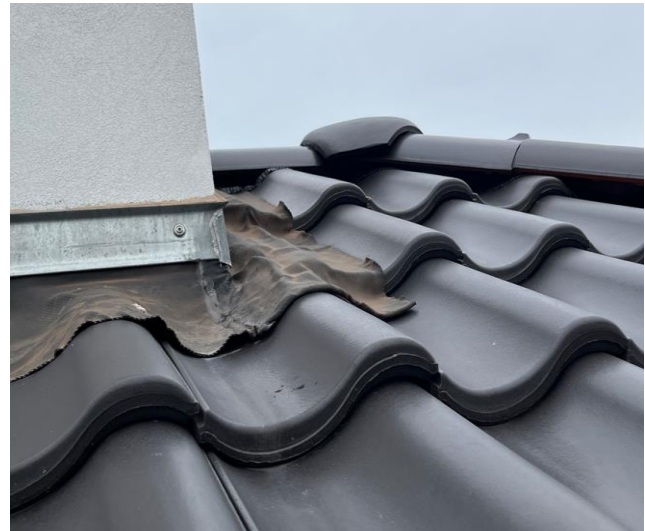
Foto 4: Snydeskorsten i træ Esthervej 16
