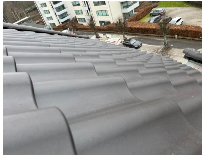
Foto 6: Tagbelægning imod vest
