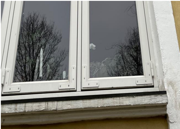
Foto 1: Vindue mod øst bolig
