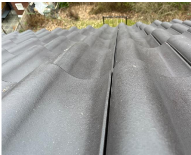
Foto 3: Tagbelægning imod øst
