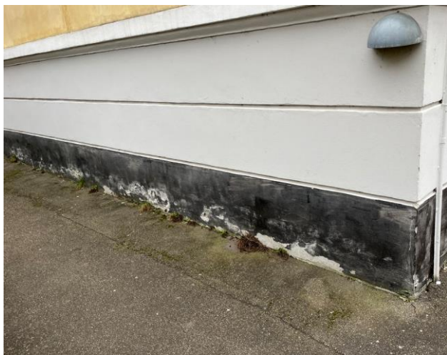
Foto 1: Gavlsokkel mod nord Esthervej 16A
