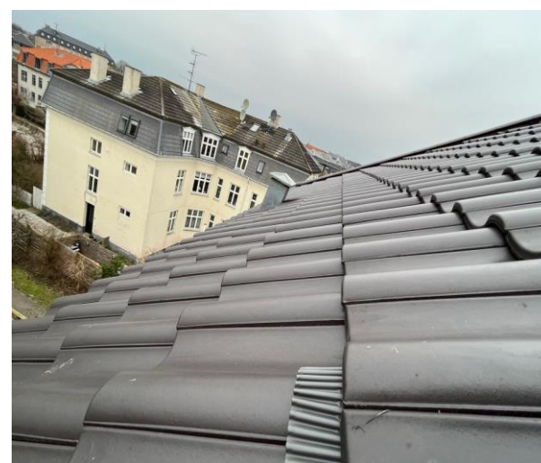
Foto 4: Tagbelægning imod vest
