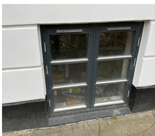
Foto 6: Kældervindue mod øst
